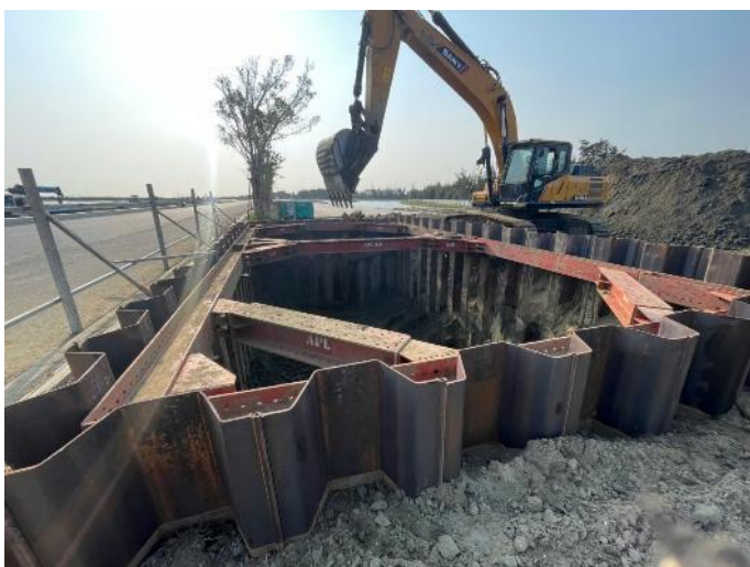
Hình 3. Hình ảnh thực tế thi công cừ ván thép kiểu mũ (loại 25H) tại dự án Cần Giờ
