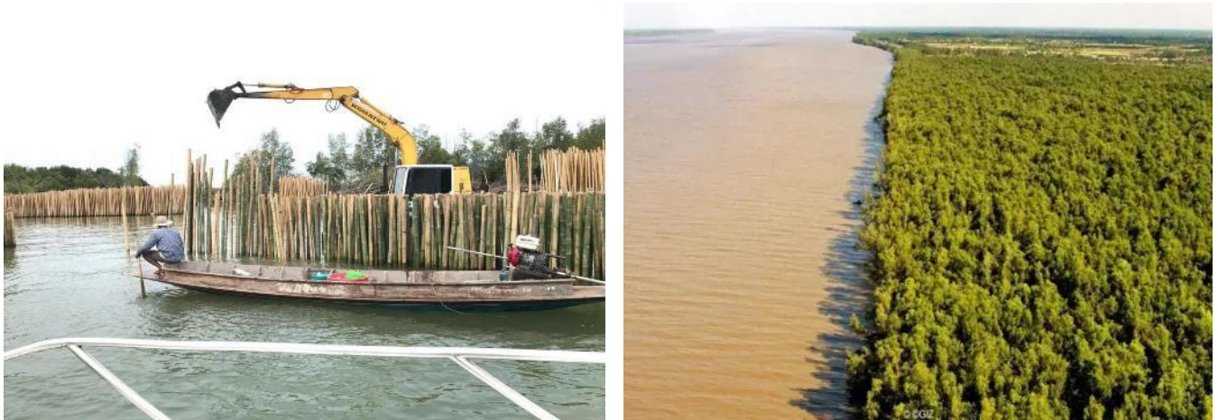
Hình 6. Một số giải pháp tự nhiên bảo vệ bờ sông – bờ biển: Trái: sử dụng bamboo, Phải: Mangrove
