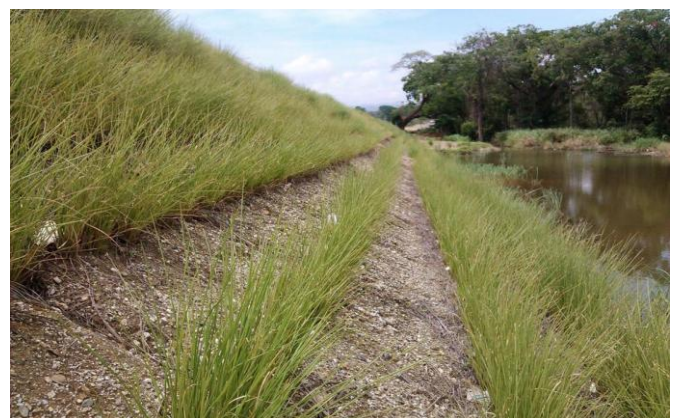
Hình 5. Một số giải pháp tự nhiên bảo vệ mái dốc sử dụng cỏ Vetiver
