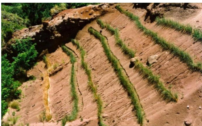
Hình 5. Một số giải pháp tự nhiên bảo vệ mái dốc sử dụng cỏ Vetiver
