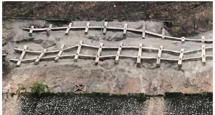
Hình 2b. Gia cố bằng neo đất FUA của SE Corporation
