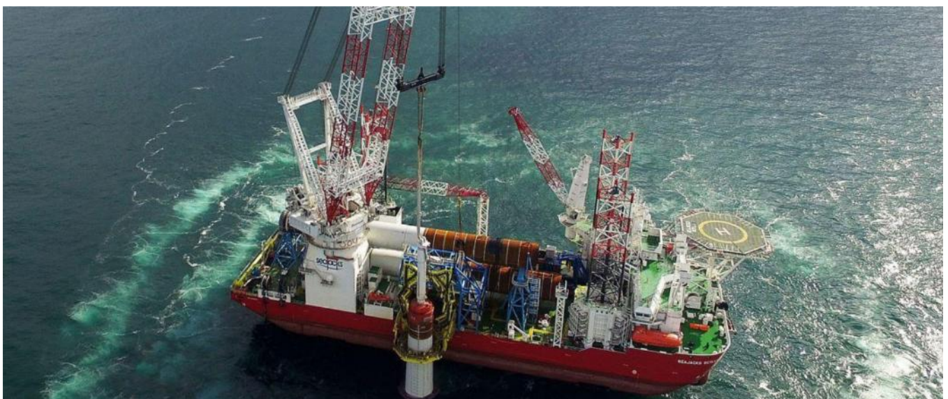
Hình 2a: Thi công cọc monopile tàu Scylla (jack-up vessel)
