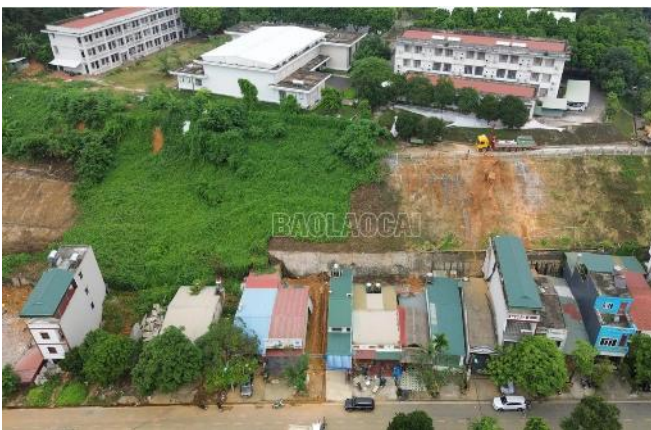
Hình 3. Khu vực một loạt nhà bị ảnh hưởng bởi trượt taluy giáp trường chính trị tỉnh Lào Cai ( www.vietnam.vn )
