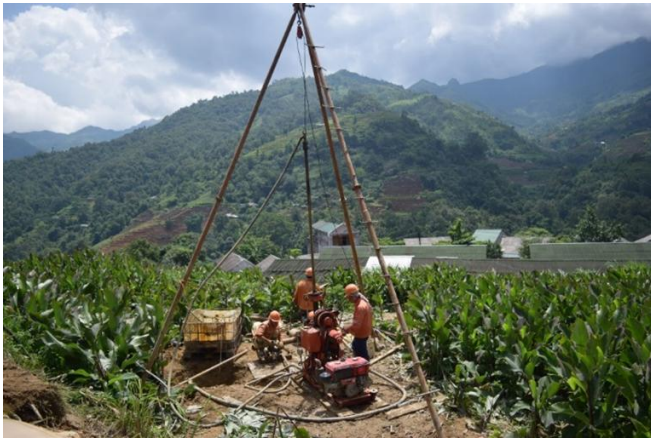
Hình 9. Lắp đặt các cảm biến trong hố khoan
