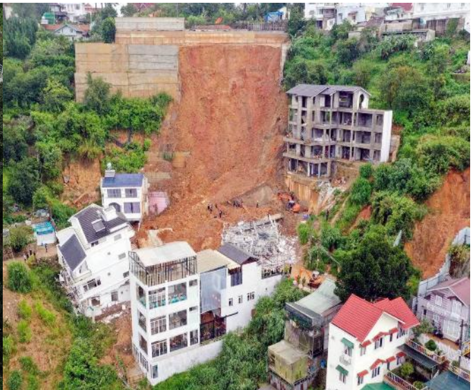
Hình 2 sạt lở năm 2023 tại taluy trên đường Hoàng Hoa Thám – thành phố Đà Lạt ( www.nhandan.vn )
