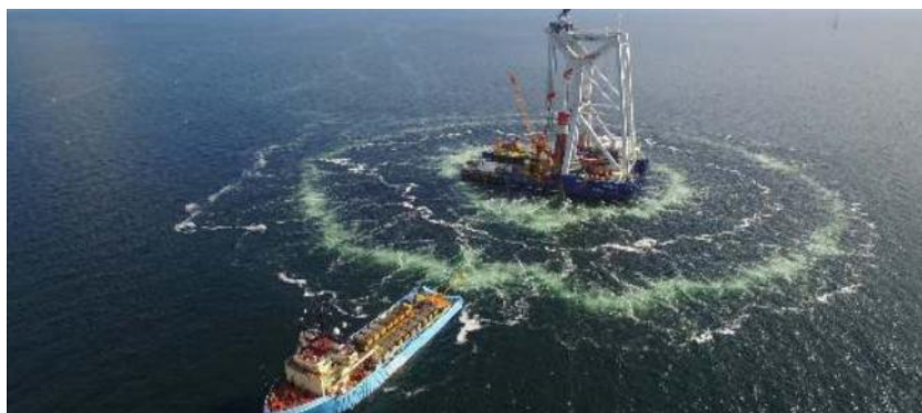
Hình 2b: Thi công monopile tàu neo đậu Svanen
