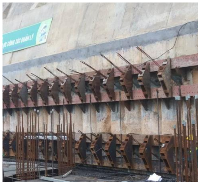
Hình 10. Cọc Secant pile bê tông cốt thép trước và sau khi được neo
