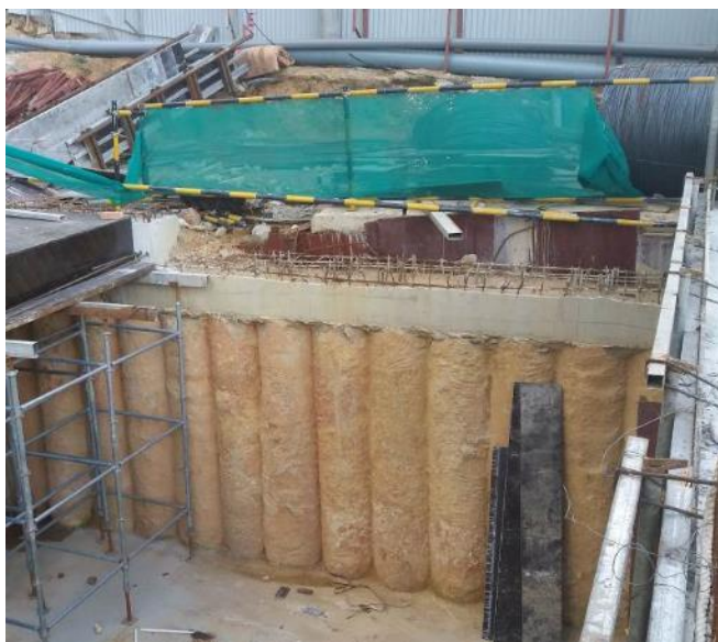
Hình 10. Cọc Secant pile bê tông cốt thép trước và sau khi được neo
