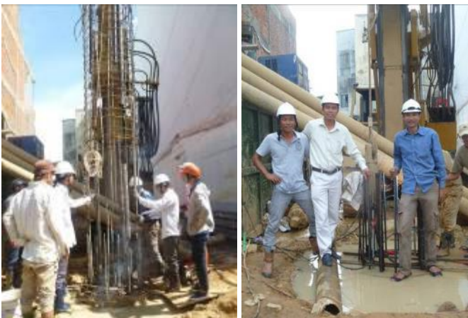
Hình 5. Lắp đặt thiết bị
