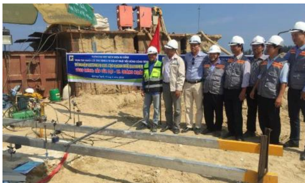
Hình 10. Công trường gia tải thí nghiệm
