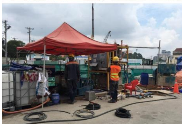
Hình 3- Xử lý CG ngăn nước ngầm thấm vào nhà ga Ba Son - Dự án Metroline 1-TP HCM
