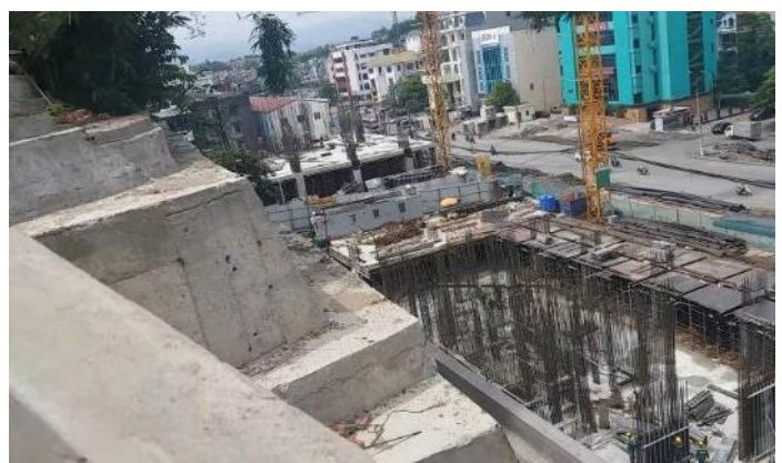
Hình 9. Kè và hệ cọc secant pile cọc 16m
