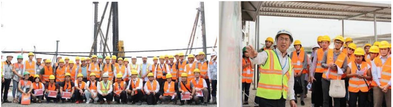
Hình 5 Tham quan công trường tại dự án Lotte Mall Hà Nội và Nhà máy xử lý nước thải Yên Xá.
