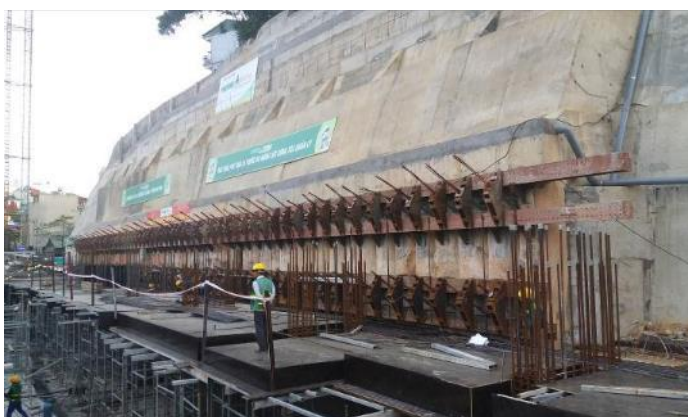
Hình 9. Kè và hệ cọc secant pile cọc 16m
