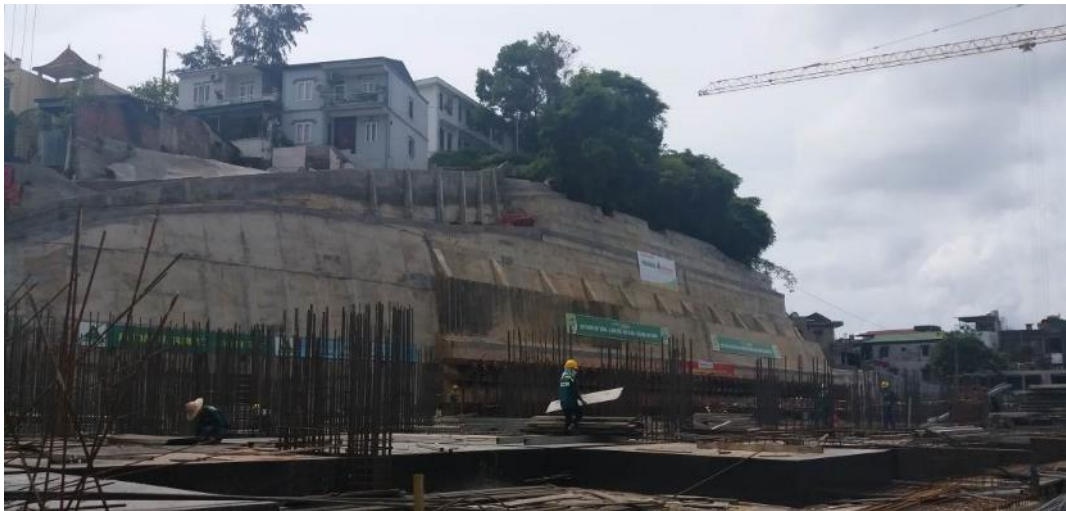
Hình 8. Hình ảnh toàn bộ kè và hệ cọc Secant pile phía sau sát dự án
