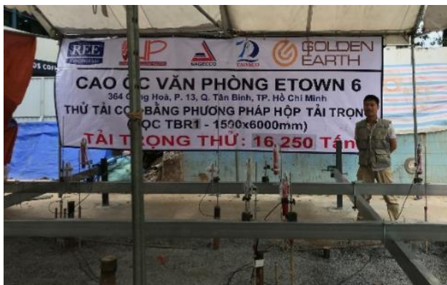
Hình 8. Lắp đặt thiết bị đo chuyển vị tại hiện trường tại dự án E-Town 6
