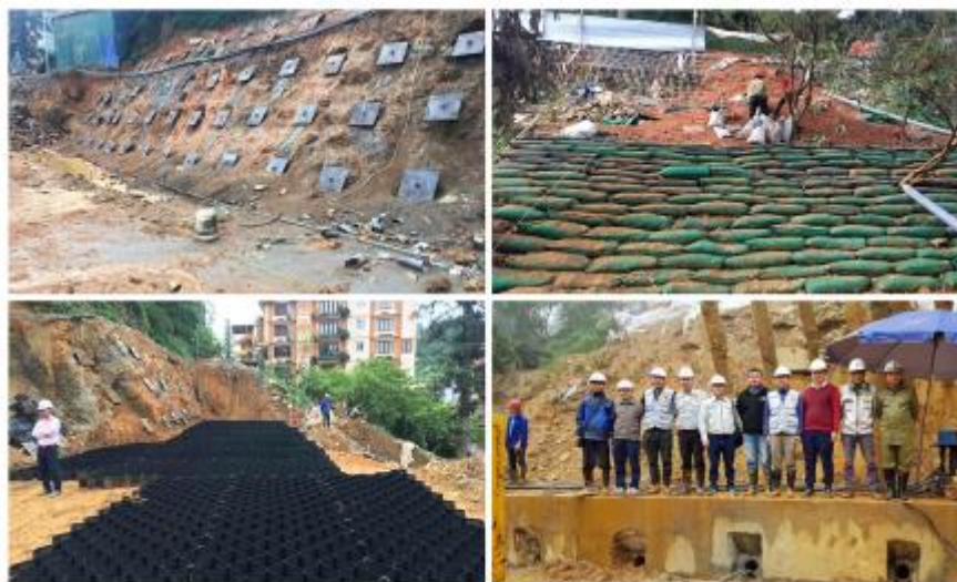
Ảnh 2: Hình ảnh thi công dự án đường Hoàng Diệu
