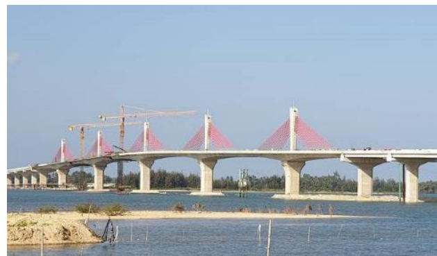
Hình 11. Hình ảnh cầu gia đoạn thi công
