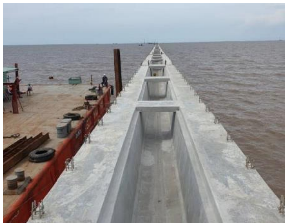
Dầm U cho hệ cầu dẫn
