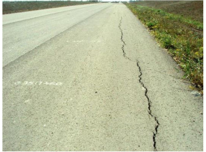
Hình 4. Những vết nứt bề mặt đường bởi co ngót của đất (Darrel Holmquist, 2019)
