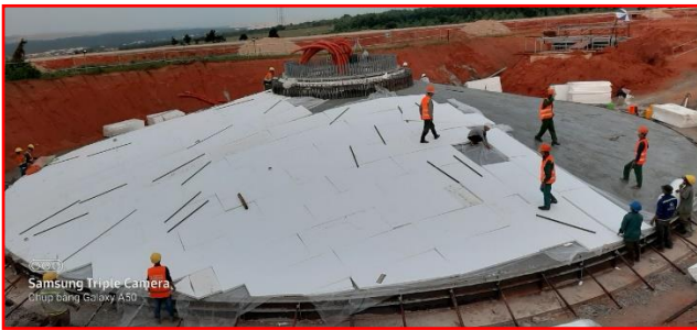
Hình 8. Bảo dưỡng bê tông: (a) bảo dưỡng bằng antisol; (b) bảo dưỡng bằng bao tải đay
