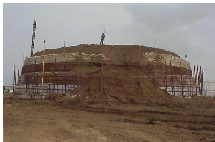
Hình 6. Chất tải giảm lún tại Nhà Bè. TP HCM
