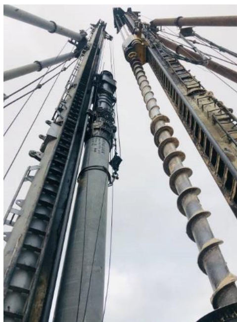
Hình 7. Thi công khoan dẫn tại dự án B&T Quảng Bình
