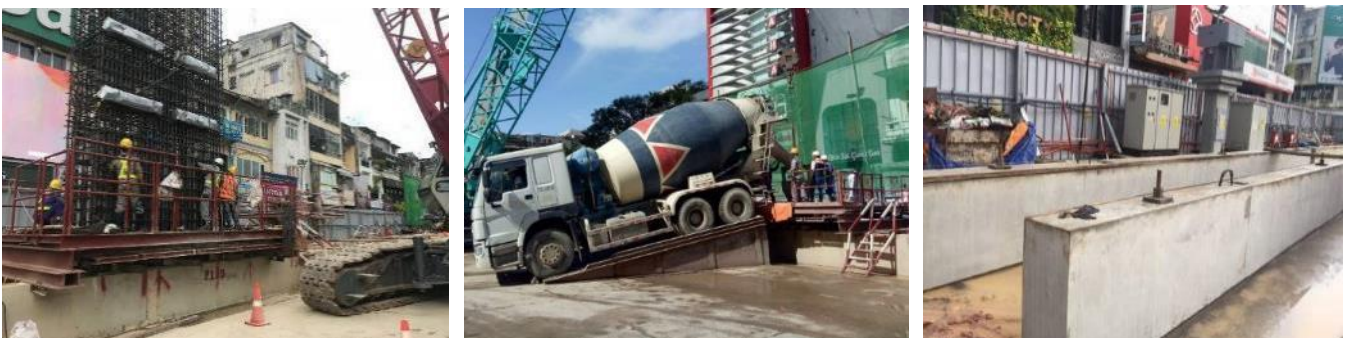
Hình 9. Một số biện pháp thi công phù hợp việc nâng cao tường dẫn.
