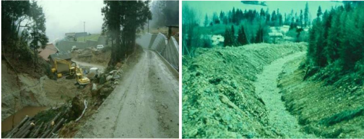
Hình 8. Công trình tường chắn dòng ở Nhật (trái) và đê chắn dòng ở đảo Vancouver (phải) (Photo: H. Nasmith) (Nguồn: Mt. Unzen)
