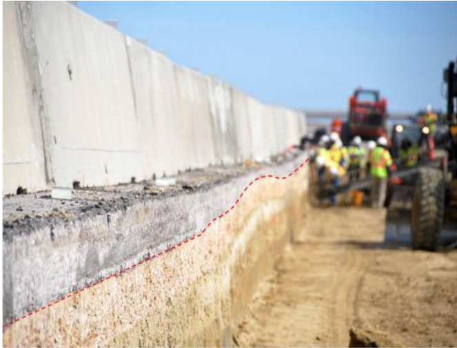
Hình 3. Sự trương nở của đất sau khi xây dựng đường (Darrel Holmquist, 2019)
