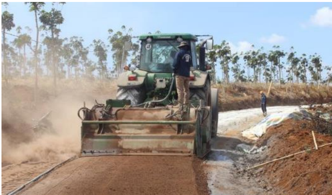
Hình 2. Thi công đường bằng đất tại chỗ trộn puzolan tự nhiên, xi măng và vôi tại Đắk Nông
