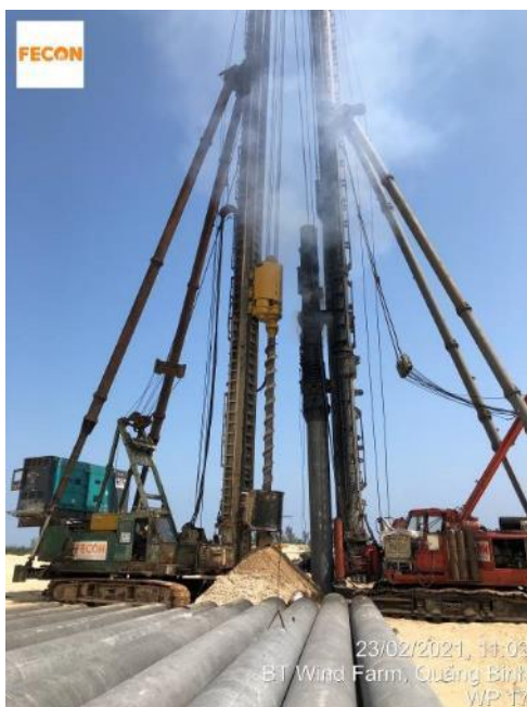
Hình 7. Thi công khoan dẫn tại dự án B&T Quảng Bình
