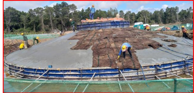
Hình 8. Bảo dưỡng bê tông: (a) bảo dưỡng bằng antisol; (b) bảo dưỡng bằng bao tải đay
