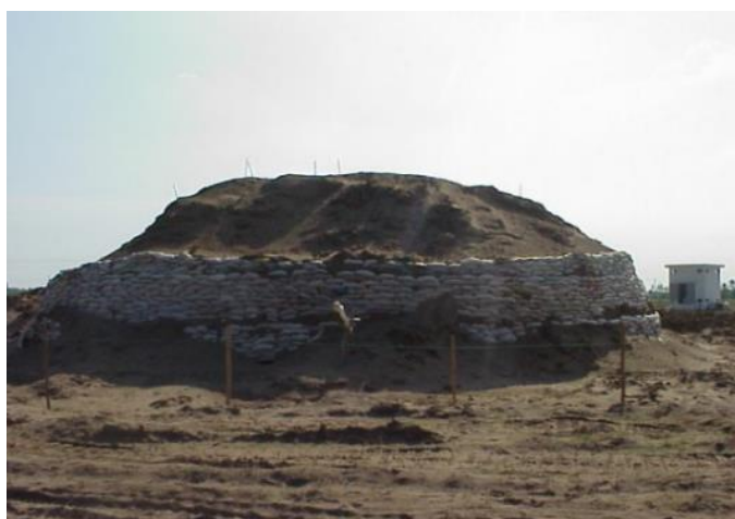
Hình 5. Thí nghiệm chất tải toàn phần
