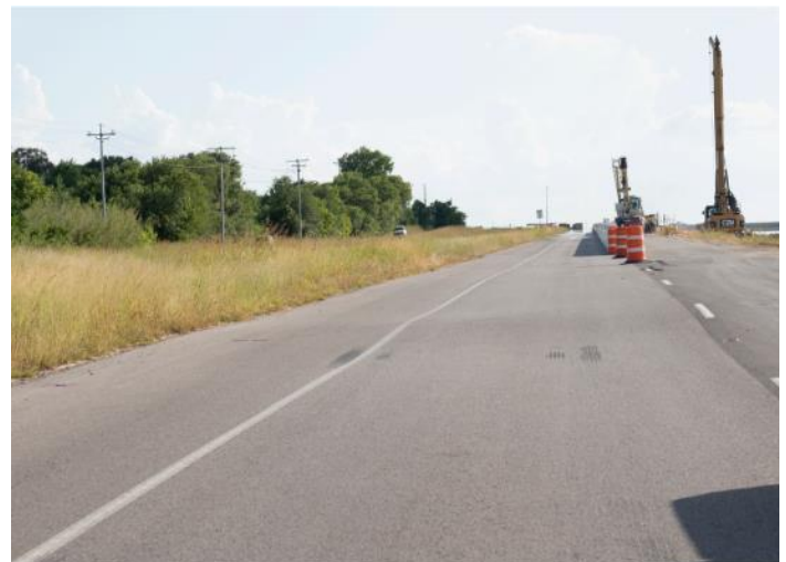
Hình 2. Nhấp nhô bề mặt đường bởi sự trương nở của đất (Darrel Holmquist, 2019)
