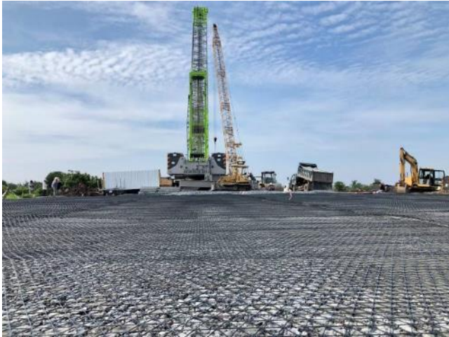
Hình 1. Hình ảnh Lưới địa kỹ thuật 3 trục Tensor gia cố sàn cầu, nền đường sau đó đổ cốt liệu lên phía trên
