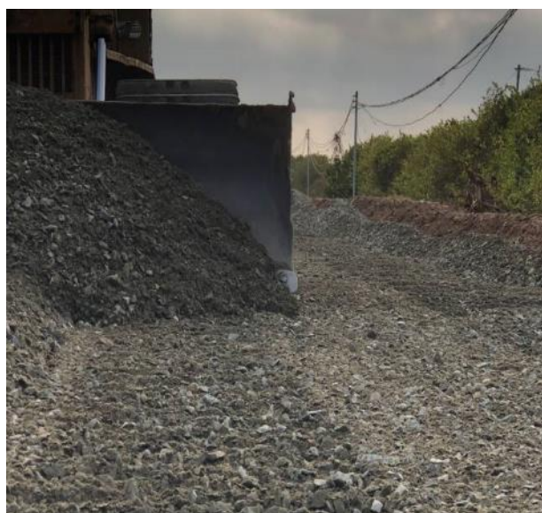
Hình 4. Hình ảnh thi công cấp phối đá dăm loại II
