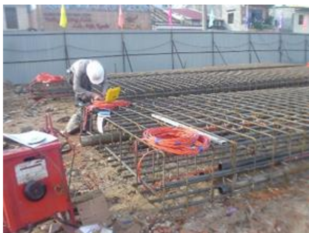
Hình 3. Lắp đặt thiết bị đo biến dạng cho thí nghiệm cọc Barrett ở Đà Nẵng - 2008 (Bachy Soletanch – C&E Consultants )
