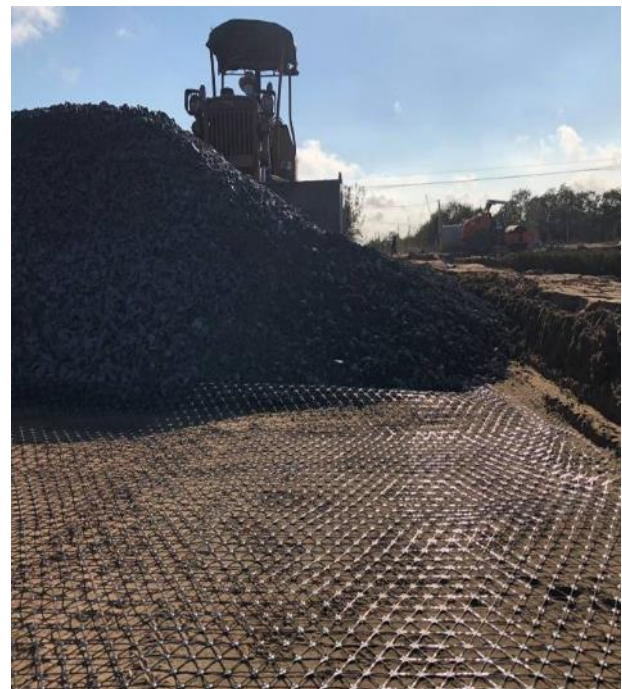
Hình 6. Hình ảnh thi công trải lưới trên nền cát tôn tạo
