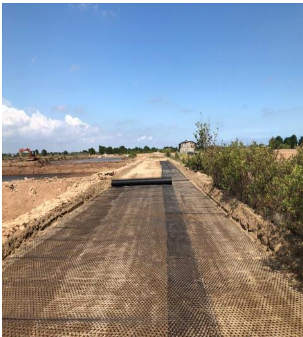
Hình 6. Hình ảnh thi công trải lưới trên nền cát tôn tạo
