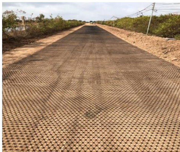
Hình 3. Hình ảnh trải lưới trực tiếp trên nền đất
