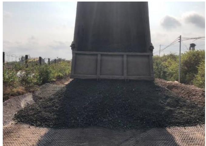
Hình 1. Hình ảnh Lưới địa kỹ thuật 3 trục Tensor gia cố sàn cầu, nền đường sau đó đổ cốt liệu lên phía trên
