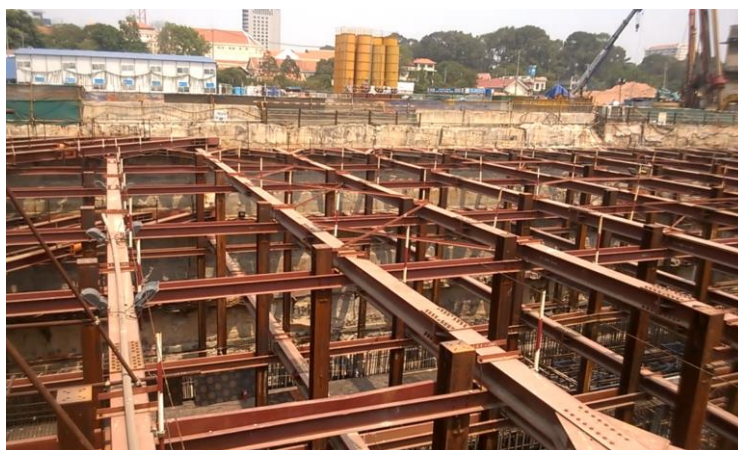
Hố đào sâu cho nhà ga Bến Thành
