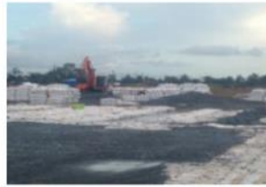
Giới thiệu công nghệ túi đất (D-Box) gia cố nền đất công trình
