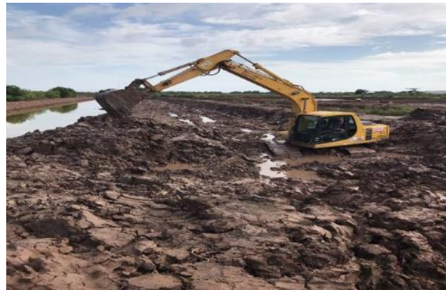
Hình 5. Hình ảnh thi công khuôn đường qua đầm tôm
