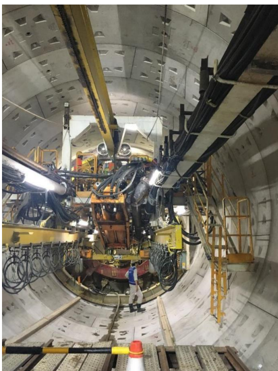
Thi công hầm bằng phương pháp TBM
