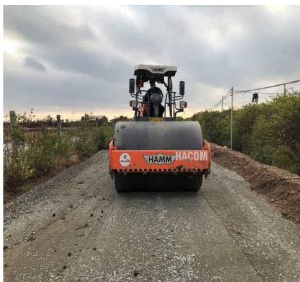
Hình 4. Hình ảnh thi công cấp phối đá dăm loại II
