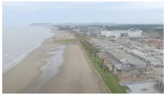
Hình 7. Đoạn kè lấn biển tạo quảng trường nhìn từ flycam
