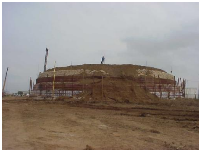
Hình 2. Thí nghiệm chất tải toàn phần trên nền gia cố trụ xi măng-đất tại Nhà Bè TP. Hồ Chí Minh (2009) COFEC
