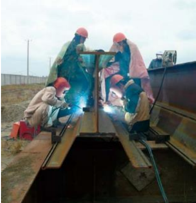
Hình 1. Công tác hàn nối cọc ván thép tổ hợp
