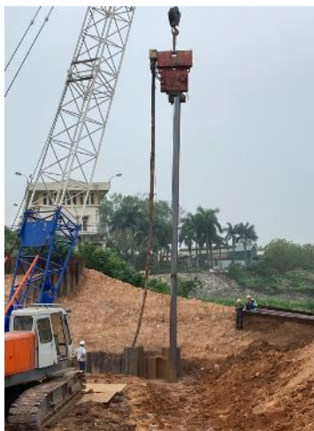
Hình 5. Thi công bằng búa rung
