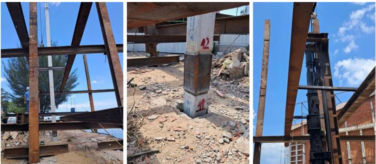
Hình 7. Thi công cọc vuông 350 x350
