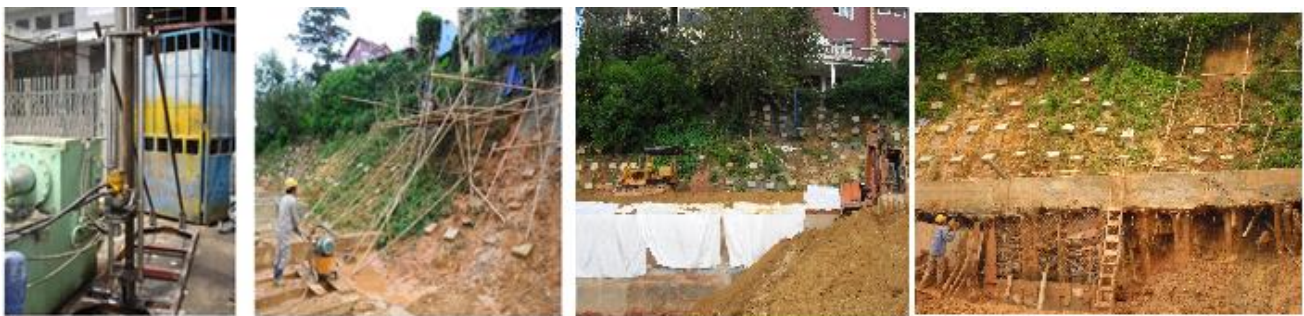
Hình 3. Máy khoan tự chế, thi công đing, đắp đất và tường đứng
