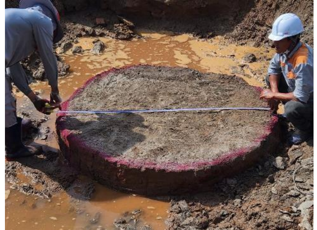
Hình 9. Đào lộ kiểm tra đường kính trụ RAS
