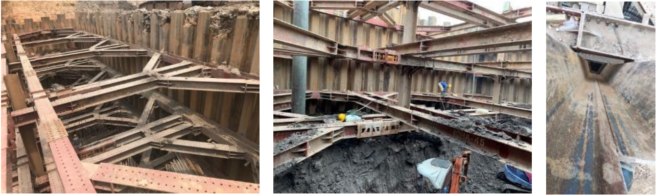
Hình 11. Hiện trạng tường chắn sau khi đào đào đất
