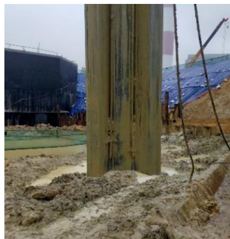
Hình 6. Biện pháp xói nước
