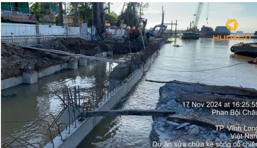
Hình 14. Thi công bản ngưỡng theo con nước.
