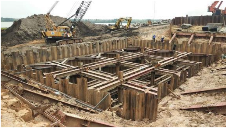
Hình 7. Hiện trạng thi công tổng thể
