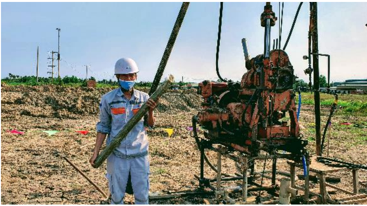
Hình 4. Khoan lõi kiểm tra chất lượng trụ Jet grouting
