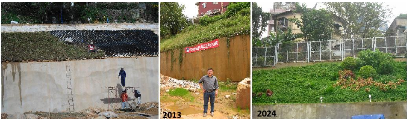
Hình 4. Thi công Geo-Cell, tác giả và một góc công trình 2024.
