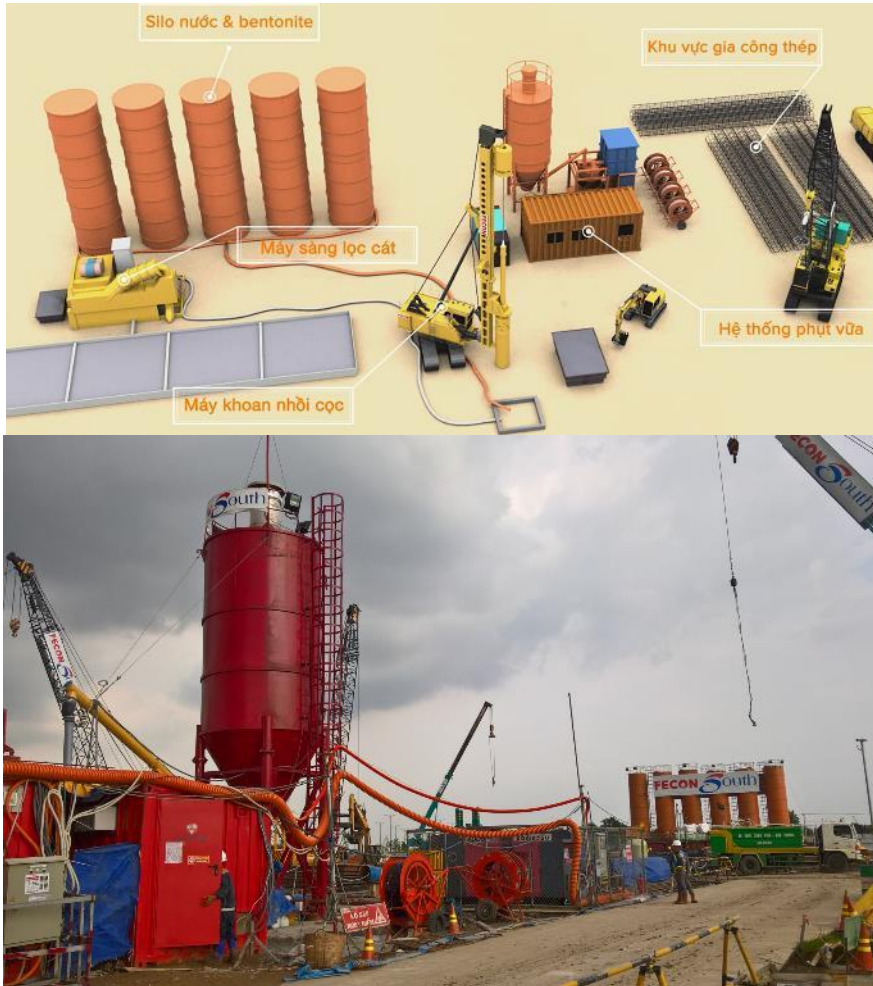
Hình 4. Sơ đồ bố trí hệ thống thi công cọc khoan nhồi phục vữa thân cọc tại công trường
