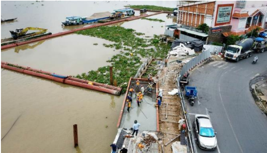
Hình 13. Thi công vỉa hè
