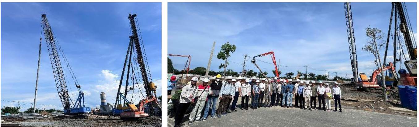
Hình 1. Các hội viên đi thăm dự án thi công cọc BTLT tại Đà Nẵng
