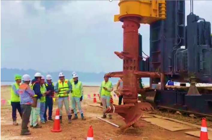
Hình 8. Thi công trụ RAS
