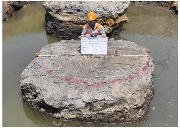
Hình 5. Đào lộ kiểm tra đường kính trụ Jet grouting
