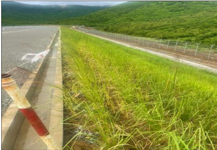
Hình 1. Ứng dụng cỏ Vetiver trong trong gia cố taluy đường dẫn vào nhà máy nhiệt điện Vân Phong, Khánh Hòa
