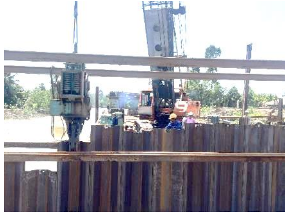
Hình 6. Thi công cừ chống thấm tại dự án Cống Vàm Long Huê - Bến Tre bằng búa rung
