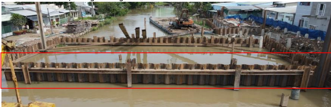
Hình 9. Hàng cừ chống thấm đang được thi công (khung màu đỏ)
