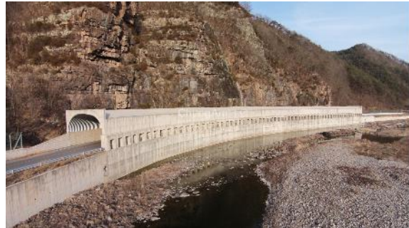
Hình 7. Bán hầm tránh đá rơi trên đường ô tô (ChungAmEnC®, 2024) [10]
