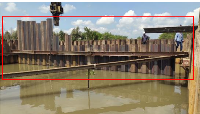
Hình 15. Thi công cừ chống thấm NS-SP-10H (khung màu đỏ)
