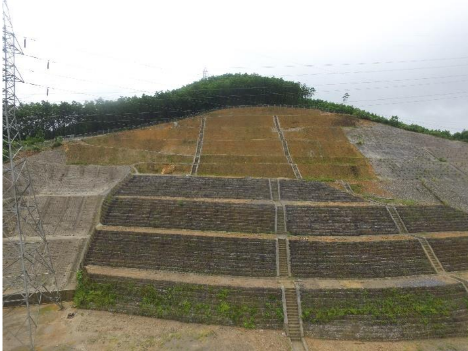
Hình 8. Mái dốc sau gia cố tại km 34
