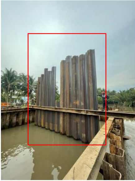
Hình 13. Thi công cừ chống thấm NS-SP-10H (khung màu đỏ)
