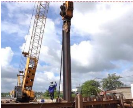
Hình 7. Cừ Mũ tại công trường
