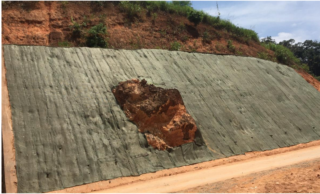
Hình 1. Hình ảnh thực tế của mái dốc thực hiện thí điểm trải lưới Takino.
