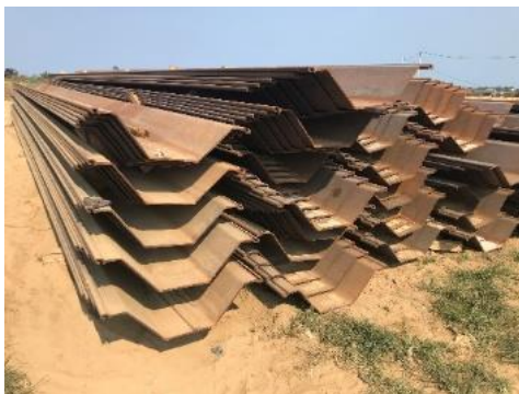
Hình 10. Cừ Mũ tại công trường
