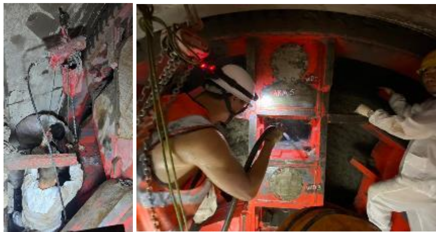
Hình 13. Thay răng cắt trong khối Jet Grouting
