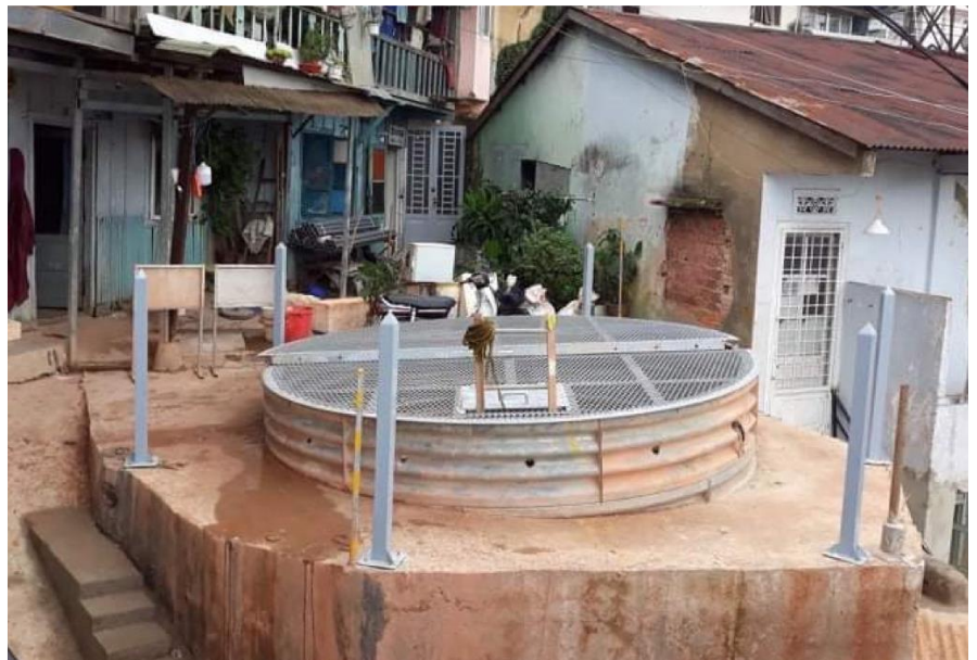
Hình 6. Giếng thu nước thi công bằng tấm lắp ghép Liner Plate.
