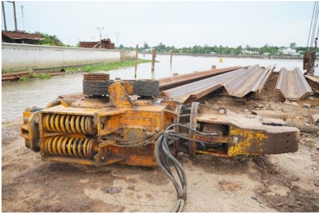
Hình 5. Thi công cừ chống thấm tại Cống ngăn triều Dầu Sấu – Cần Thơ bằng búa rung
