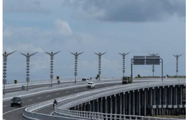
Hình 2: Cầu dạng bản trên cọc BTCT ly tâm dự ứng lực ở Bali, Indonesia
