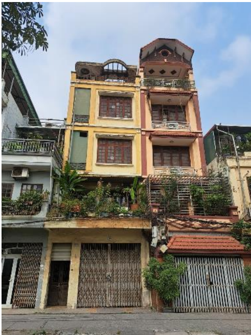
Hình 2. Nhà 258 đường Giải Phóng, HN.
