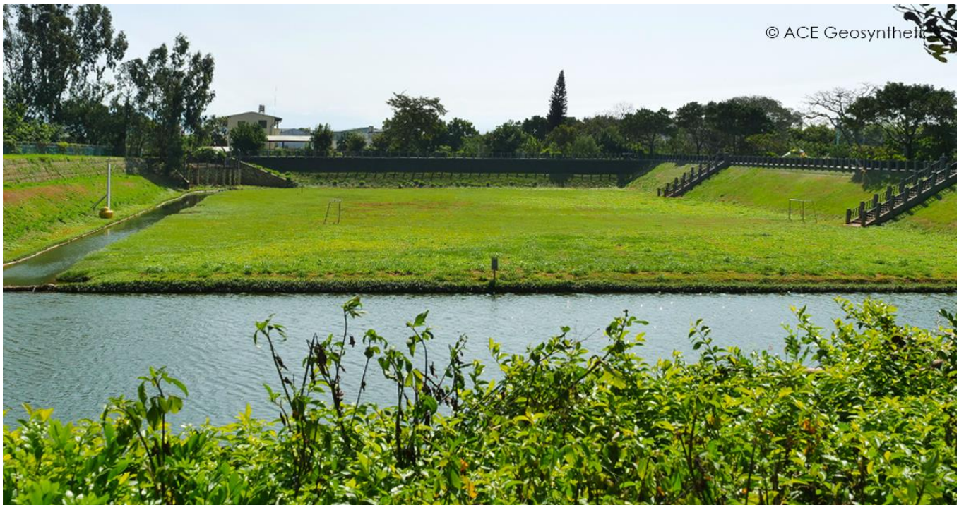
Hình 1. Hồ điều hòa với kè đất gia cố cho sông Fazi, Đài Trung, Đài Loan
