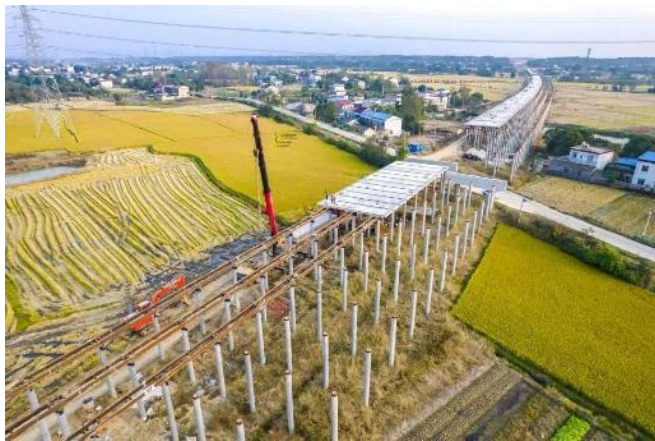
Hình 3: Cầu dạng bản trên cọc BTCT ly tâm dự ứng lực ở Hà Nam-Trung Quốc
