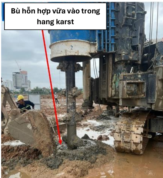
Hình 3: Thiết bị rung lắc mạnh và mất dung dịch khoan khi gặp hang karst
