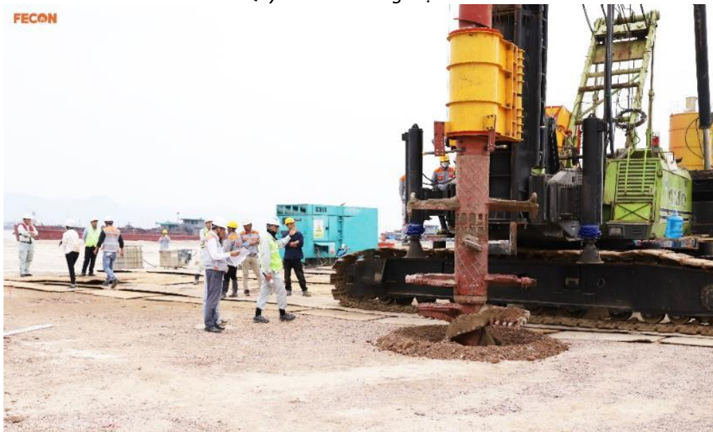
Hình 8. Thi công trụ thử RAS tại dự án
