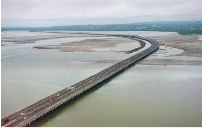
Hình 2: Cầu dạng bản trên cọc BTCT ly tâm dự ứng lực ở Bali, Indonesia
