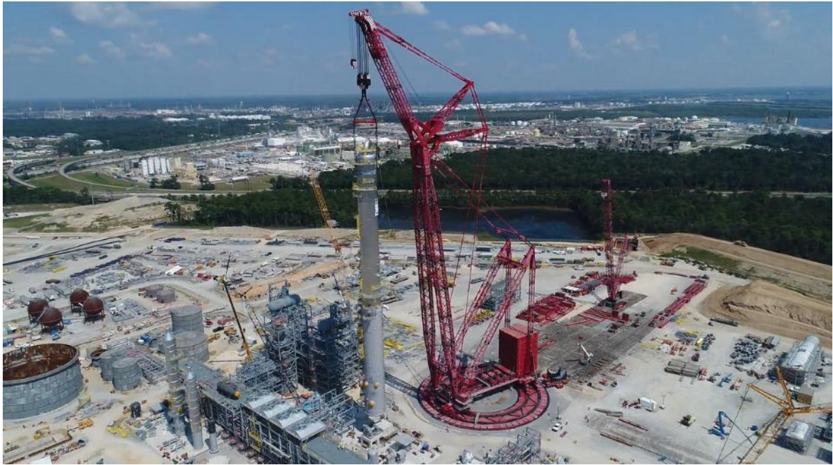
Hình 8. Tháp rửa được nâng lắp đặt bởi cần trục PTC-200 DS (ảnh Mammoet Fabrication B.V.)
