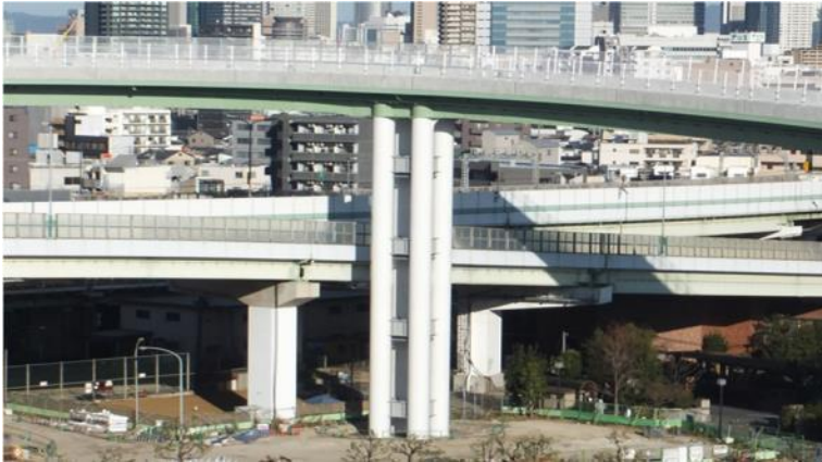
Hình 2. Kết cấu cầu vượt trong đô thị sử dụng trụ CFT ở Nhật Bản [1]
