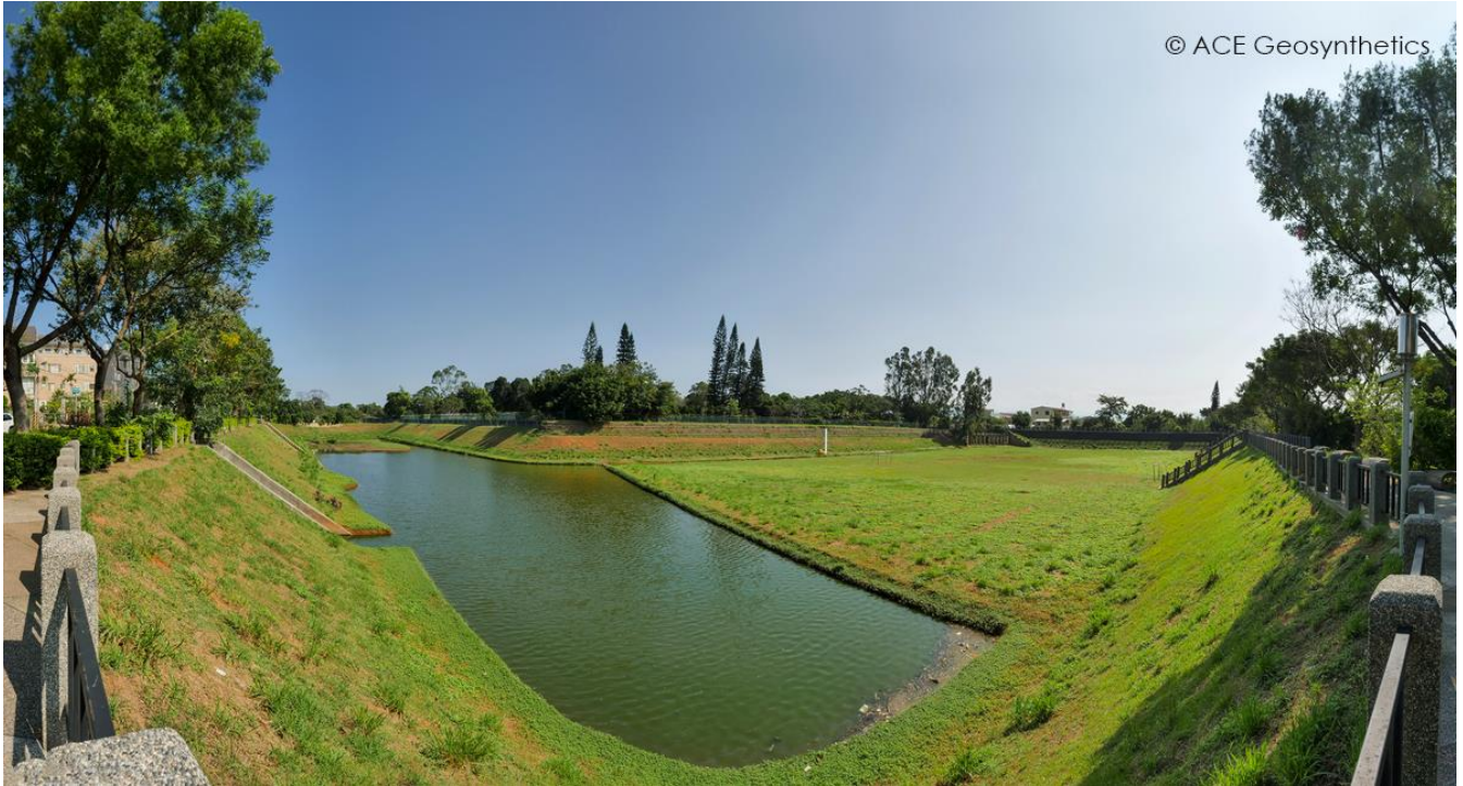
Hình 5. Toàn cảnh hồ điều hòa sau khi thi công xong
