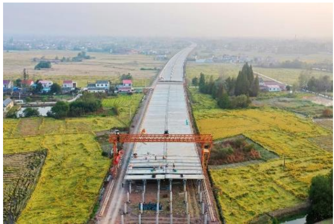
Hình 3: Cầu dạng bản trên cọc BTCT ly tâm dự ứng lực ở Hà Nam-Trung Quốc
