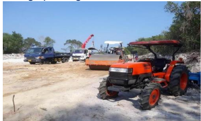
Hình 9. Lu nền chặt mặt bằng trước thi công lớp gia cố
