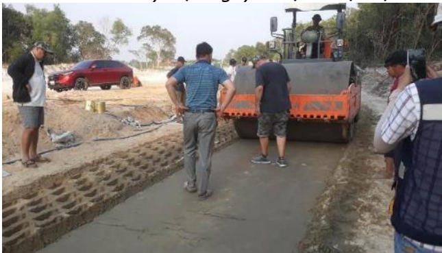
Hình 14. Lu nền đất sau khi trộn & tưới phụ gia
