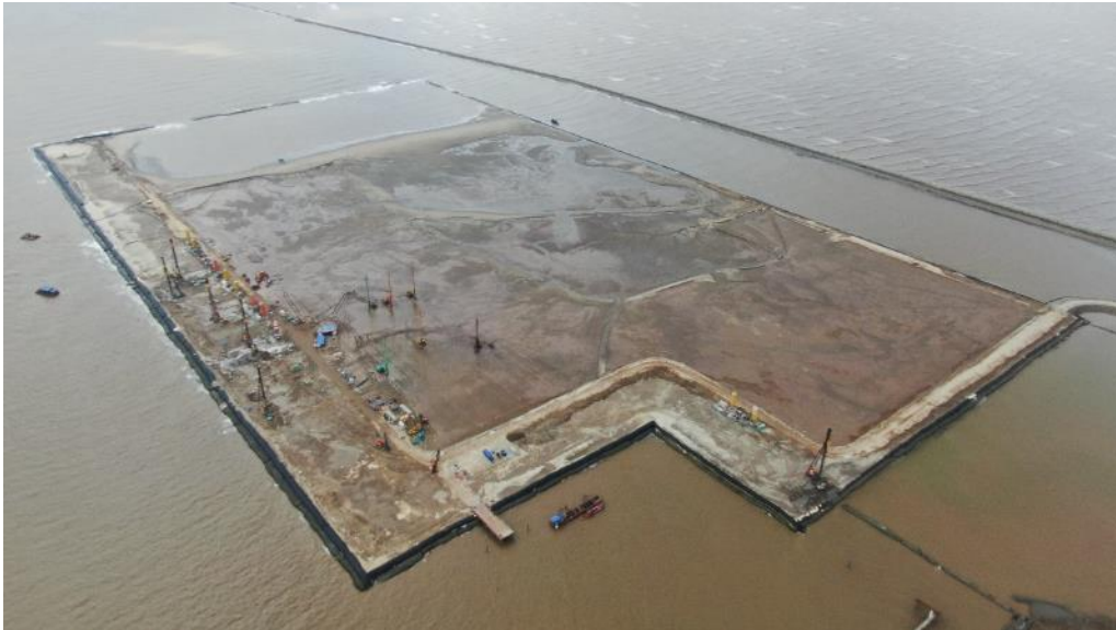
Hình 9. Thi công trụ RAS trong giai đoạn đại trà (sáu dây chuyền thi công đồng thời)
