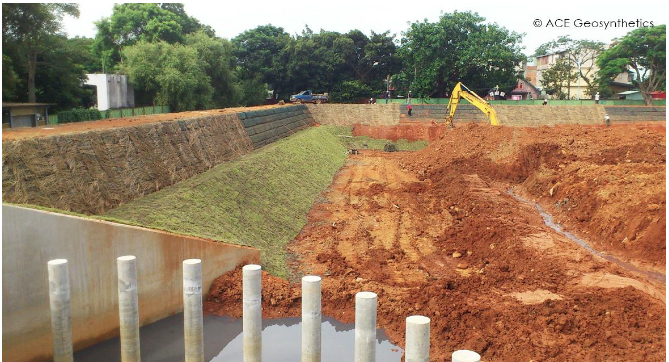
Hình 4. Quá trình thi công và hoàn thiện kè hồ điều hòa
