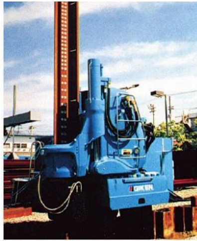
Hình 5. Thi công bằng máy ép tĩnh
