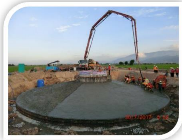
Hình 6 : Hình ảnh lắp đặt thép và đổ bê tông móng
