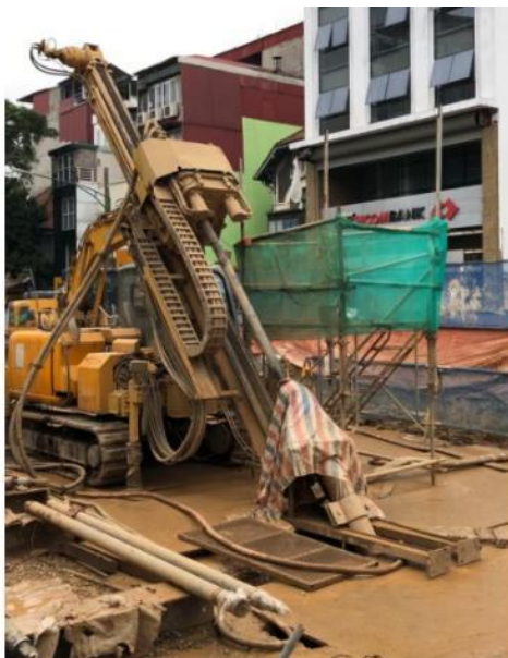
Hình 4. Hình ảnh thi công tại hiện trường
