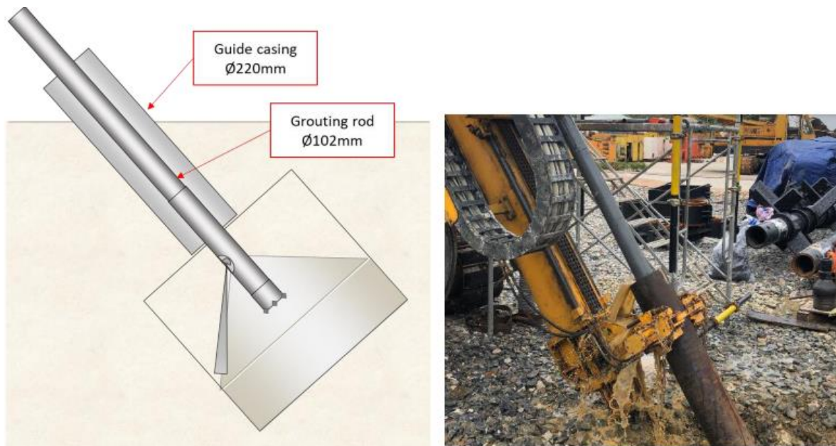
Hình 11. Sử dụng ống vách định hướng khi khoan phụt nghiêng
