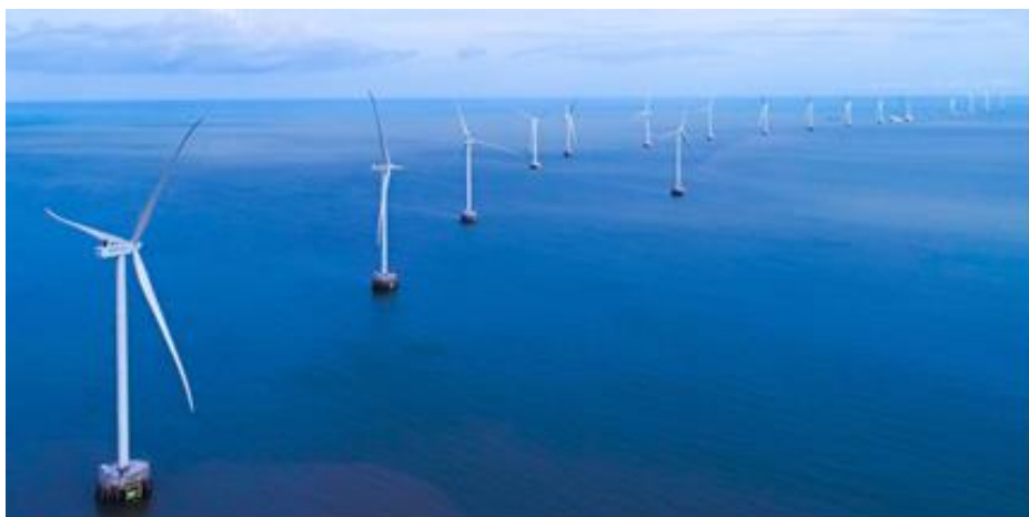
Hình 10. Móng gần bờ nhà máy điện gió Tân Thuận, 75MW, 18 tua bin.
