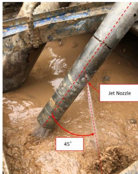
Hình 9. Thiết bị đầu phụt đã được cải tiến
