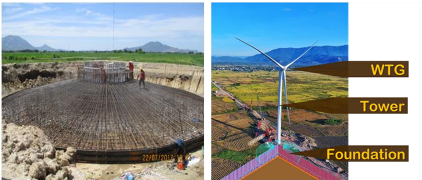
Hình 1. Cấu tạo chính của hệ thống tuabin gió và công trường xây dựng móng tuabin
