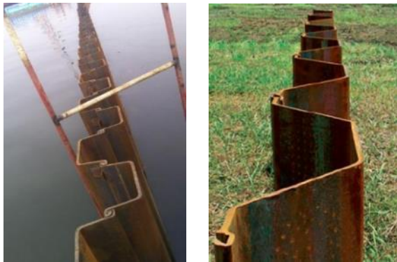
Hình 1. Cừ ván thép kiểu U (bên trái) và cừ ván thép kiểu Mũ (bên phải)
