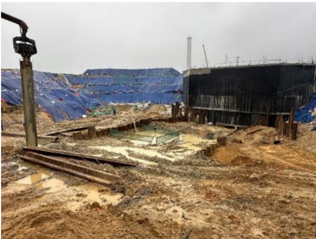
Hình 8. Búa rung đang rung hạ cừ mũ
