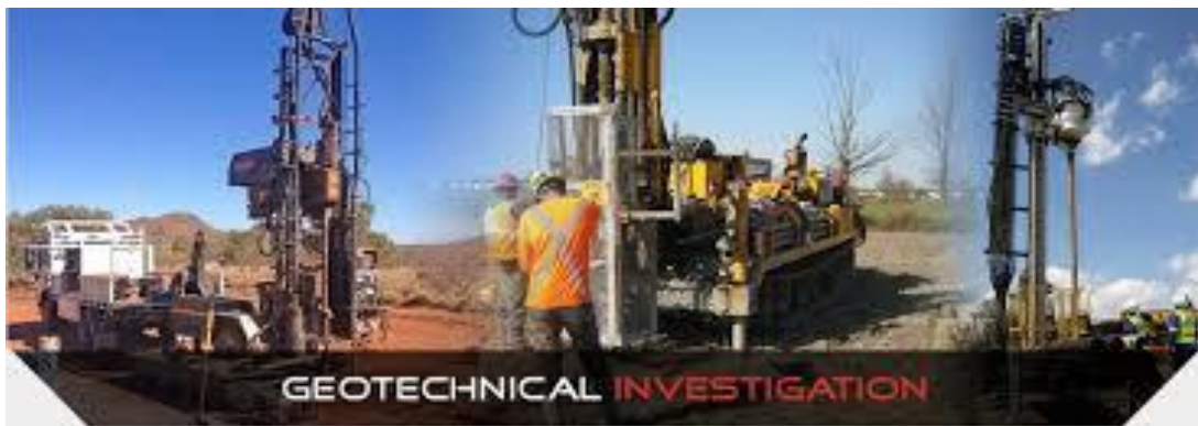
Hình 4. Khảo sát địa kỹ thuật tại công trường
