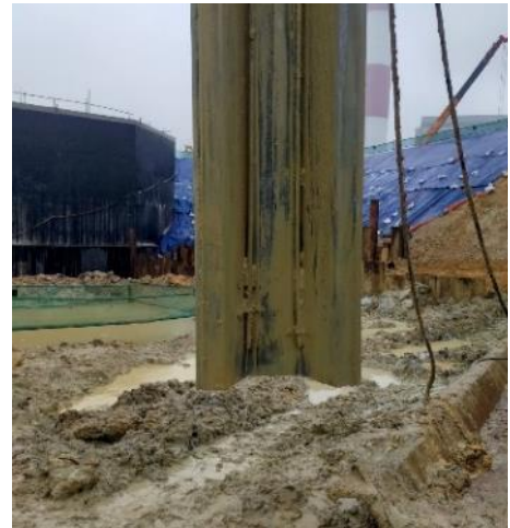
Hình 6. Biện pháp xói nước
