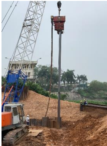
Hình 4. Thi công bằng búa rung
