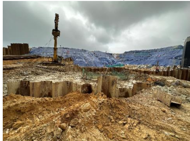
Hình 11. Một phía hàng cừ mũ đã thi công xong
