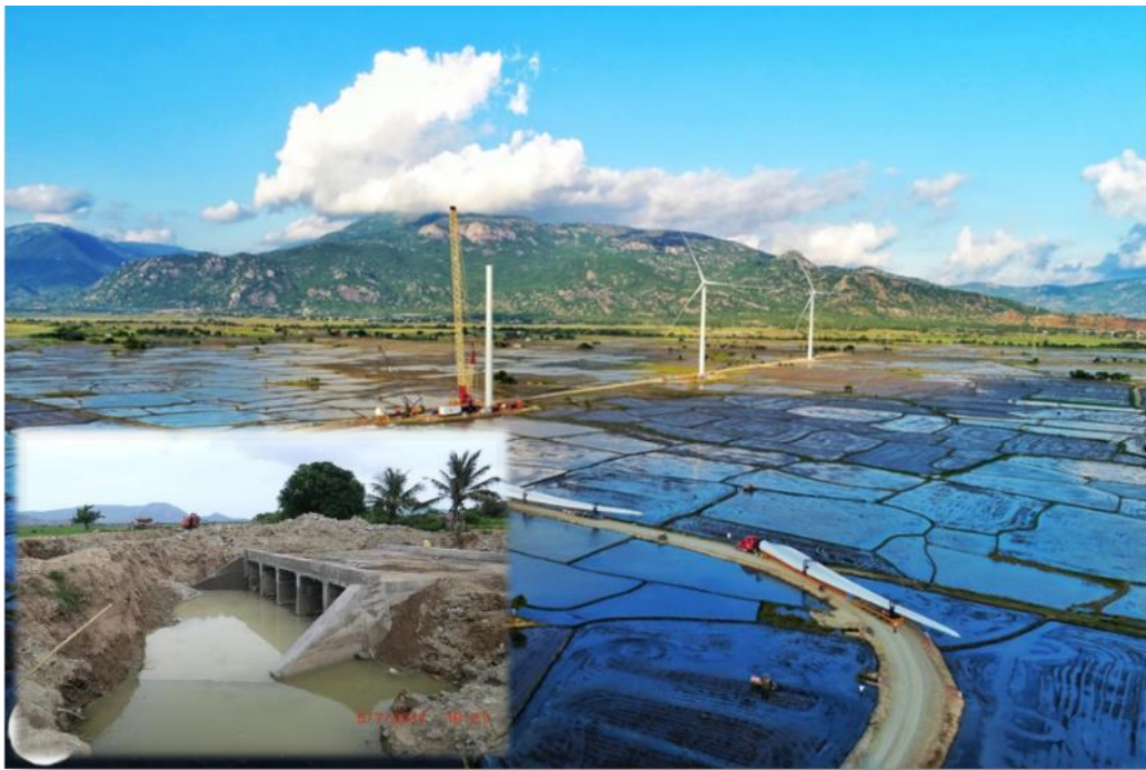
Hình 6. Thi công móng tuabine trên vùng nước nông
