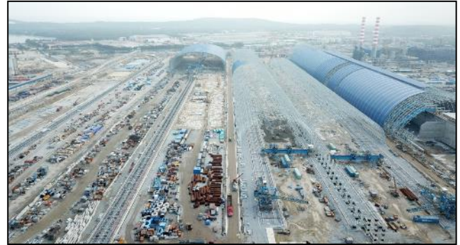
Hình 11. Bãi chứa trong quá trình hoàn thiện sau xử lý nền bằng Công nghệ đầm rung sâu
